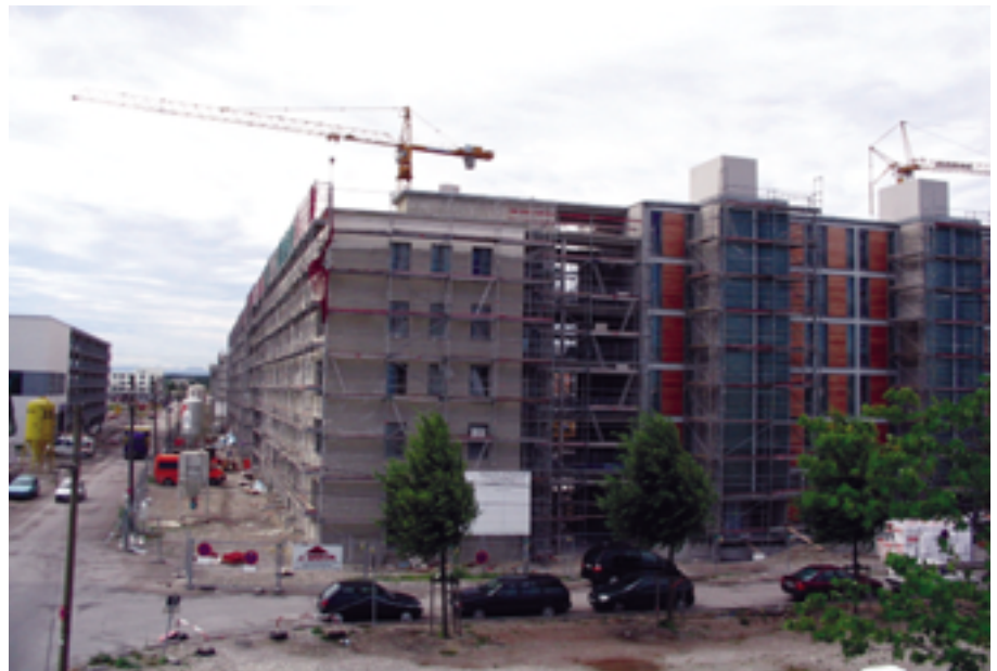
Die Wohnanlage ist mit einem Raumentlüftungs-System aus Gusseisen ausgestattet
