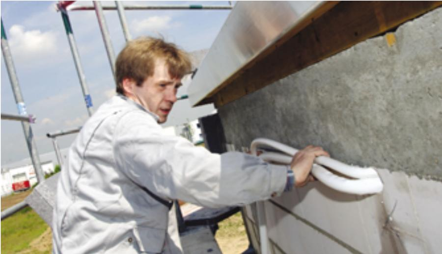
**Verlegung der isolierten Rohrleitungen vom Außen- zum Innengerät durch einen Mitarbeiter der Firma Härtel**
