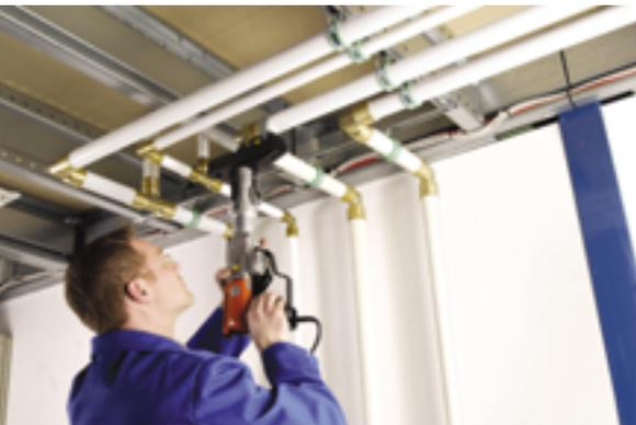
Messing ist das System für den Einsatz in Heizungsanlagen und für den Transport von Trinkwasser jeder Beschaffenheit geeignet. Für die Verarbeitung der großen Dimensionen bietet das Unternehmen ein Werkzeug für alle gängigen Pressmaschinen an. Das Presswerkzeug ist ein Schiebepkopf, welcher mit einer hydraulischen Übersetzung arbeitet. Der Werkzeugsatz wird als Set angeboten. Für die Dimensionen 14–32 mm bietet TC Handwerkzeuge an.
