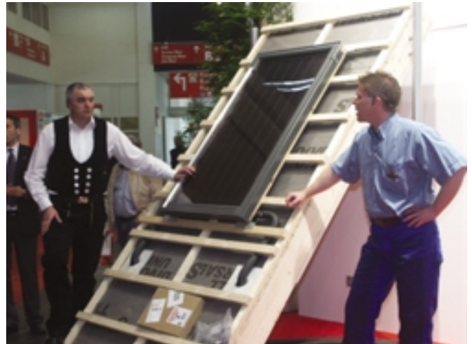
Velux setzt bei der Montage von Solar-Kollektoren verstärkt auf die Zusammenarbeit von Dachdecker-, Heizungsbau- und Klempnerhandwerk
