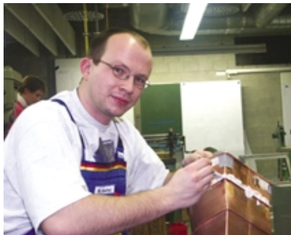
Die aufgetragene Schlammkreide verhindert ein Durchfließen des Lotes
