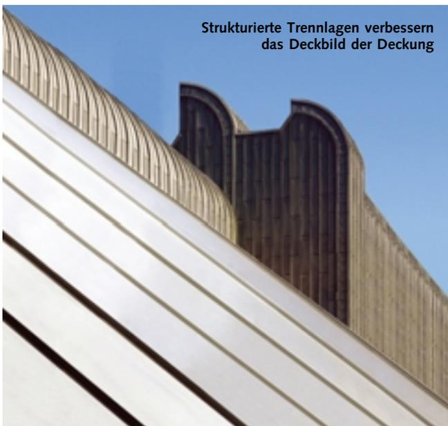
Strukturierte Trennlagen verbessern das Deckbild der Deckung
