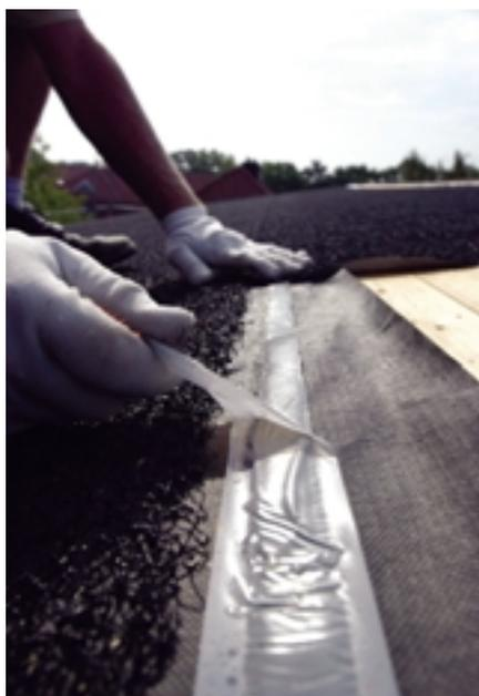
Mit dem Nahtverschluss entsteht eine regensichere, wind- und insektendichte Trennlage
