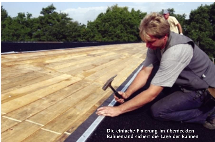
Die einfache Fixierung im überdeckten Bahnenrand sichert die Lage der Bahnen
