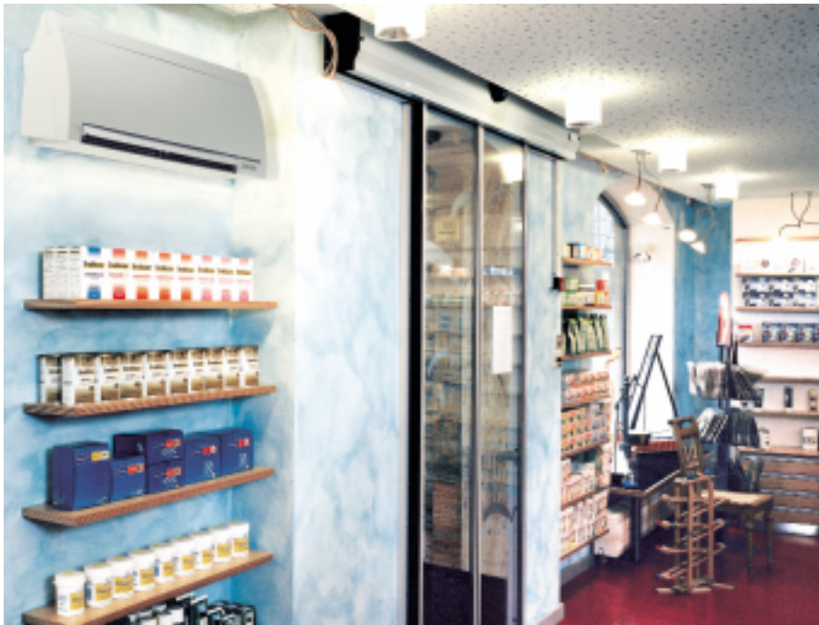
Wandhängende Raumklima-Splitsysteme, hier in einer Apotheke eingesetzt
