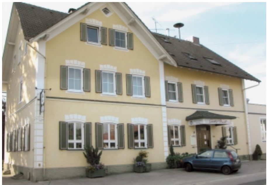
Nach umfangreichen Umbauarbeiten besitzt das Gasthaus Rauch einen Wellness-Bereich, der das Aushängeschild des 3-Sterne Hotels ist
