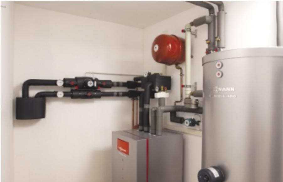
**Bild 21 Sole/Wasser-Wärmepumpe und Speicher-Wassererwärmer**
