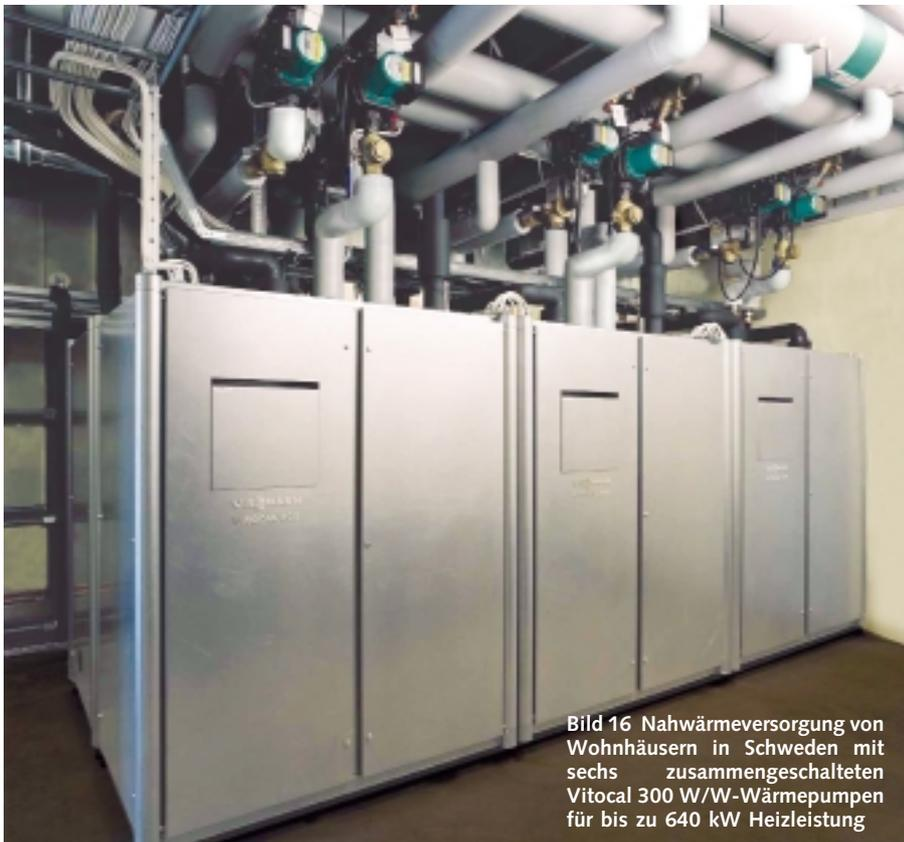
Bild 16 Nahwärmeversorgung von Wohnhäusern in Schweden mit sechs zusammenschalteten Vitocal 300 W/W-Wärmepumpen für bis zu 640 kW Heizleistung
