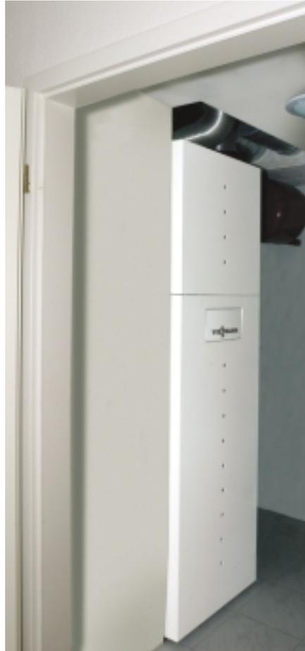
**Bild 12** Der Technikraum des Passivhauses in Herzhausen mit Kompaktgerät und Membran-Ausdehnungsgefäß für den Solarkreis (im Hintergrund)
