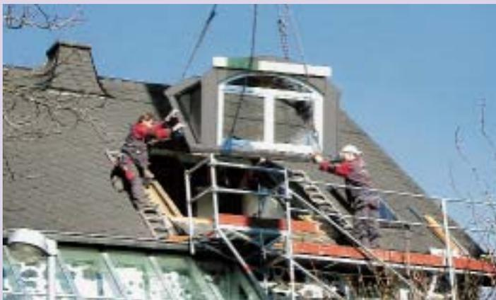
werden zur Baustelle geliefert und dort per Kran montiert. Ausgeführt in Rheinzink „vorbewittert pro“, blaugrau oder „vorbewittert pro“, schiefergrau, sind sie als Satteldach-, Walmdach-, Schleppdach-, Segmentbogendach- oder
