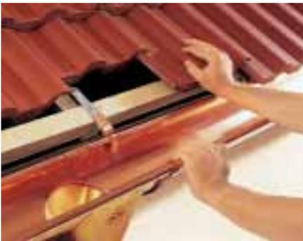
**Bild 1** Zuerst werden die Dachziegel nach oben geschoben oder die unterste Reihe abgenommen . . .
