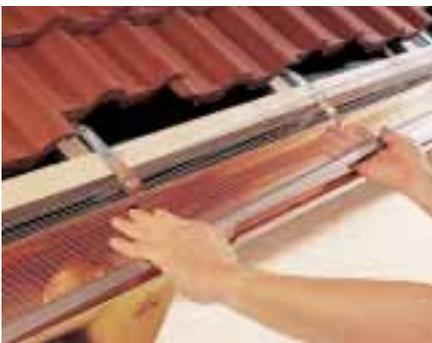
**Bild 2** . . . danach wird das Laubschutzgitter mit der Schiene am Rinnenwulst aufgelegt
