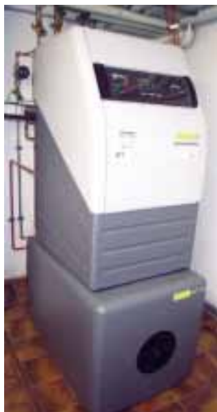
Dem Rotex-Ölbrennwertkessel im Keller der Familie Wasmeier: Von der Stiftung Warentest erhielt er als Testsieger die Note 1,7 – der Bezirksschornsteinfegermeister wettete trotzdem dagegen
