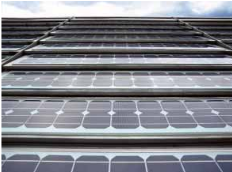
Die Südhalfe des Daches wurde mit Quick-Step-Solar-PV-Systemelementen von Rheinzink versehen
