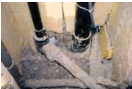
Bild 4 „System Hoffnung“: Deckendurchführungen von Abwasserrohren
