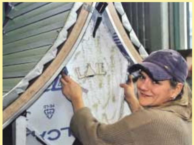
. . . bevor sie mittels Winkelstehfalztechnik in die Fassade eingearbeitet wird
