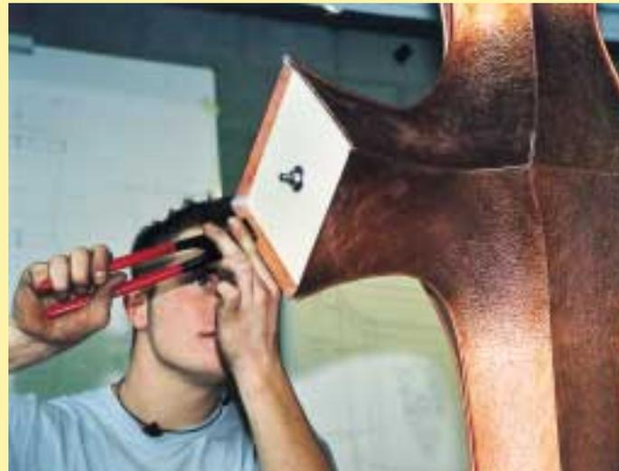
Die einzelnen Elemente des Bärenkreuzes werden durch einfache durchlaufende Stehfalze zusammengehalten
