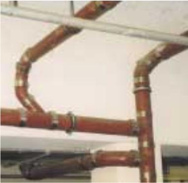
Mit der DIN EN 12056-2 und DIN 1986-100 liegen neue Grundlagen für die Berechnung von Schmutzwasserleitungen vor. Dies führt zu kleineren Nennweiten und erfordert häufiger den Einsatz von Nebenlüftungen. Was im einzelnen dahinter steckt, finden Sie ab Seite
