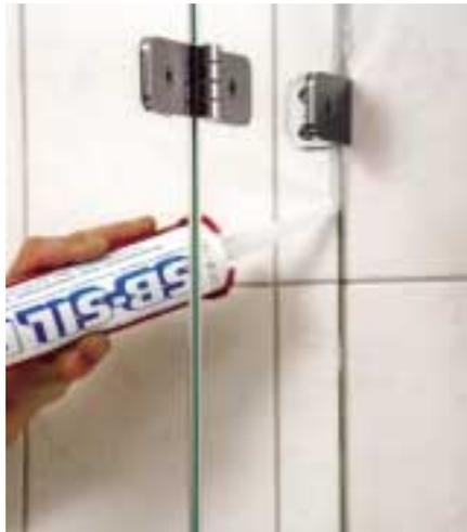
**Bild 16** Fugen zwischen Festteil und Wand sowie Festteil und Duschtassenrand werden mit Silikon abgedichtet
