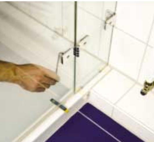
**Bild 15** Wo die Tür montiert werden soll, werden Unterleghölzer auf dem Duschtassenrand plaziert
