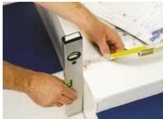
Bild 8 Mit Zollstock und Wasserwaage wird auf dem Duschtassenrand das Einrückmaß für die Außenkante der Duschtrennung übertragen
