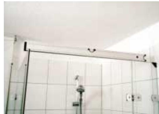
**Bild 11** Wenn beide wandseitigen Festteile montiert sind wird kontrolliert, ob die Höhen der Oberkanten übereinstimmen
