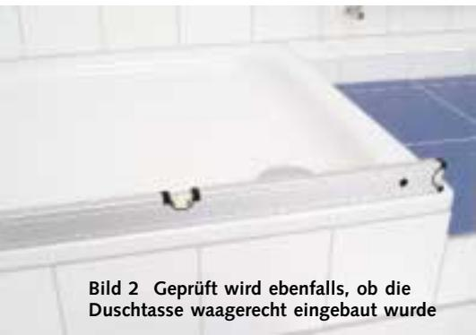
Bild 2 Geprüft wird ebenfalls, ob die Duschtasse waagrecht eingebaut wurde
