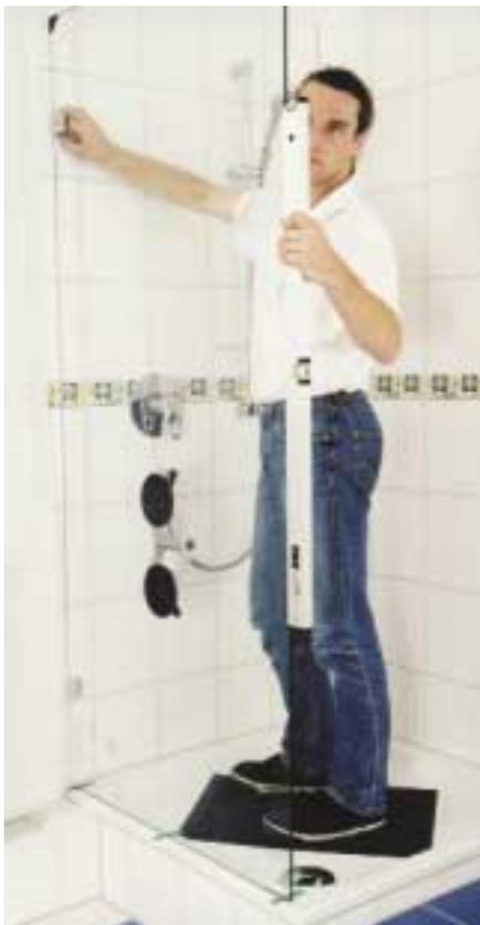
**Bild 10** Mit einem Saugnapf wird das mit dem Beschlag vormontierte Festteil auf den Rand gehoben, positioniert, lotrecht ausgerichtet und festgeschraubt
