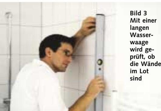
Bild 3 Mit einer langen Wasserwaage wird geprüft, ob die Wände im Lot sind
