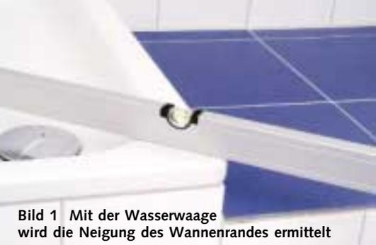
Bild 1 Mit der Wasserwaage wird die Neigung des Wannenrandes ermittelt
