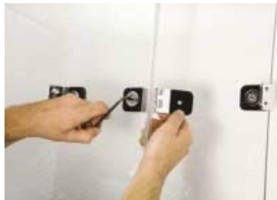
Bild 7 Wenn alle kontrollierten Teile dem Einbauplan entsprechen, können die Beschläge an den Glasscheiben montiert werden
