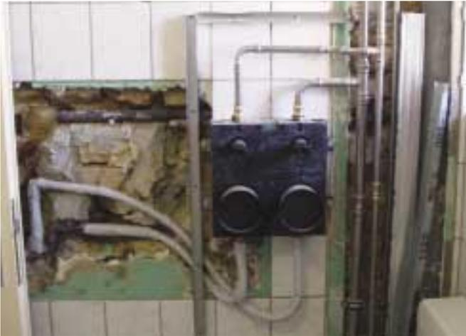
**Zeitgleich mit der Installation neuer Rohrsysteme und Armaturen wurden vorhandene Zapfstellen in Bad, Küche und WC notversorgt**
