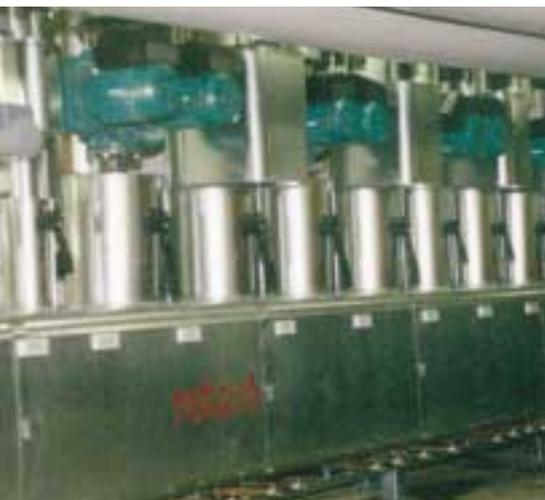
Die Verteileranlage ist der Fernwärmeübergabestation nachgeschaltet und versorgt wiederum einzelne Unterstationen
