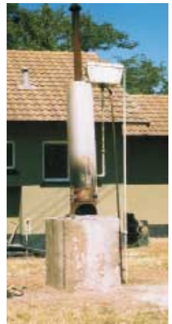
Wo ein Wille, da ein Weg: In Zimbabwe muß trotz akuter Geldnot auf warmes Wasser nicht verzichtet werden
