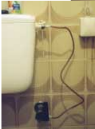
Kein Einzelfall: Außergewöhnliche Wasseranschlüsse
