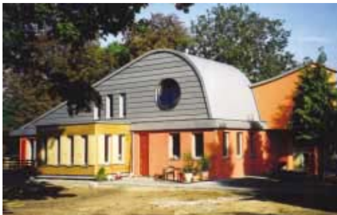
Die Dach- und Fassadenfläche wurde aus VM-Zink errichtet
