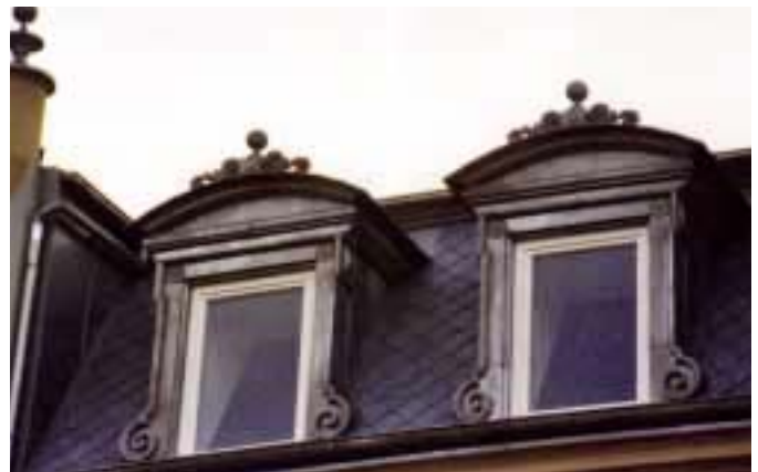
Die Mansarde wurde mit Zinkrauten eingekleidet
