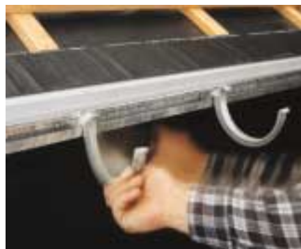
Die Montage der Rinnenhalter erfolgt durch einfaches Eindrehen
