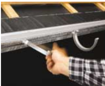
Rinnendrehhalter werden im Bereich der Sparren in die Montageschiene eingesetzt
