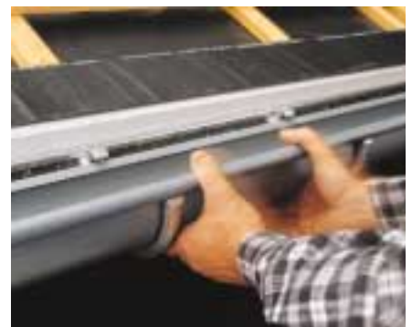
Durch Einklicken wird die Dachrinne fest und dauerhaft fixiert
