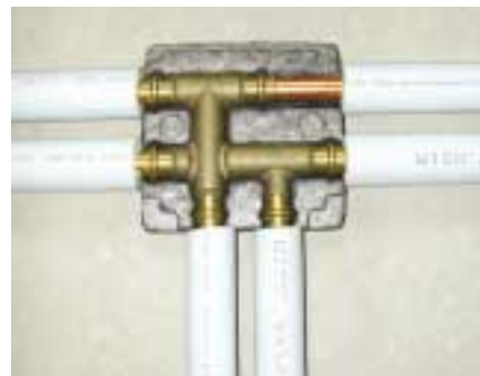
Rohrkreuzfittings zum Pressen und Löten ermöglichen das Kreuzen der Rohre auf einer Ebene und sind gleich isoliert
