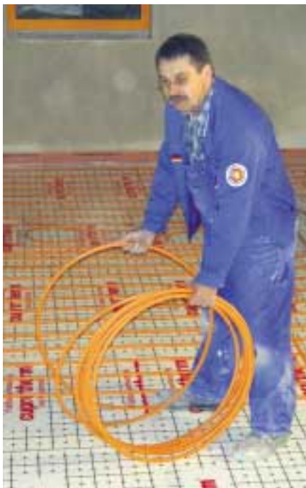
Innungs-Geschäftsführer Josef Bock bei der Rohrverlegung der „Cuprotherm“-Fußbodenheizung
