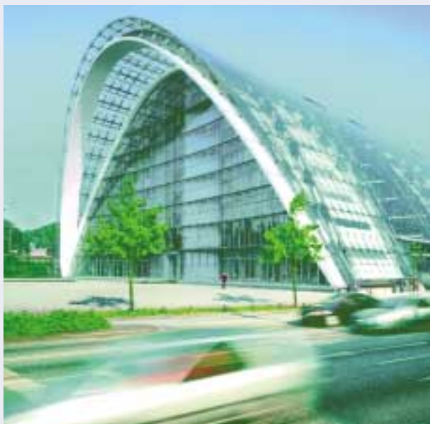
Der „Berliner Bogen“ in Hamburg wurde mit dem Immobilien-Oscar ausgezeichnet
