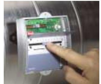
Der Synco 100 kombiniert Regler und Temperaturfühler und wird direkt in der Anlage montiert
