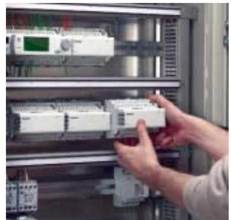
Die Synco-Universal- und Erweiterungsmodulare lassen sich per Klickverbindungen in den Schaltschrank integrieren
