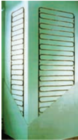
Bei der neuen „Hypoplan“-Wandheizung von KME wurde die Registerdicke reduziert
