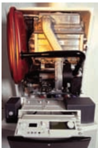
Der Brennwert-Wandheizkessel Logamax plus GB 142 von Buderus ist in den Leistungsgrößen 15, 24 und 30 kW verfügbar
