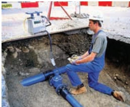
**Anschlußfitting für Polyethylenleitungen in der Gas- und Wasserversorgung von Georg Fischer**
