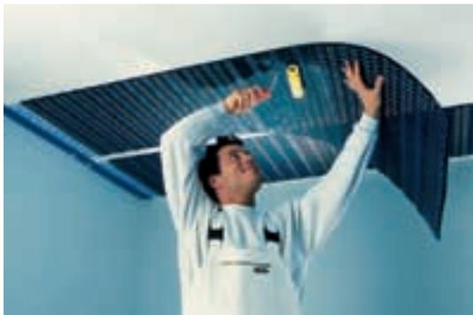
Das Polymat-Kapillarrohrsystem von Polytherm besteht aus speziellen Kunststoffmatten
