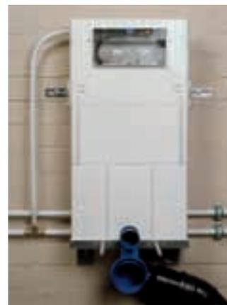
Der neue Friafix-Unterputzspülkasten von Friatec in der Naßbauvariante
