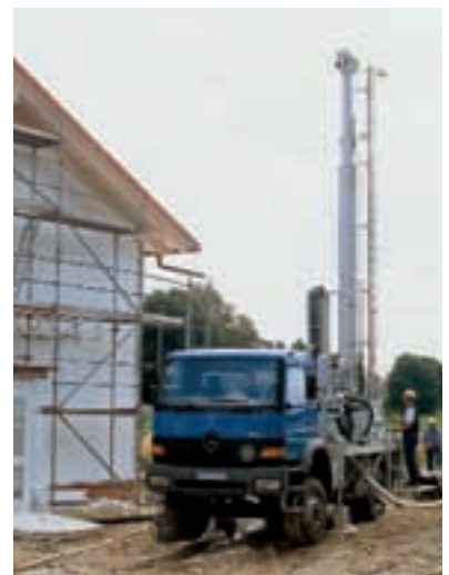
Bohrstelle für eine vertikale Erdsonde auf dem Grundstück eines Mehrfamilienhauses
