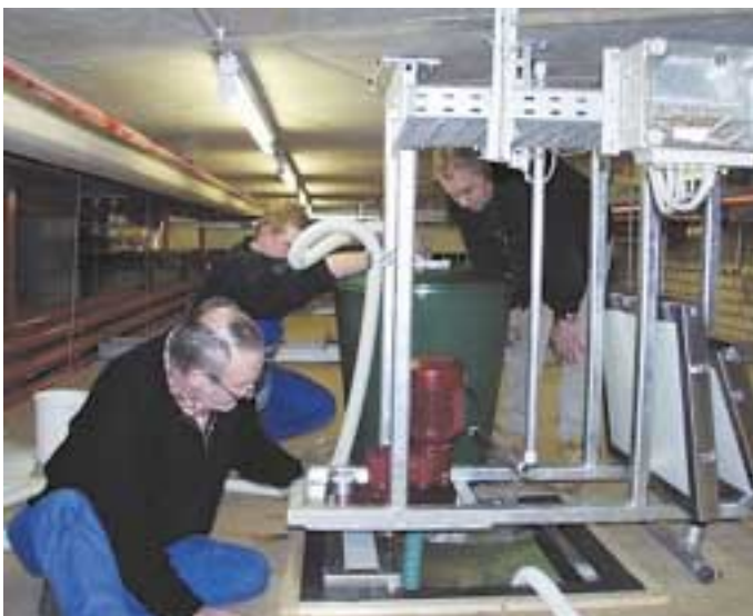
Hier wird Hobby zum Beruf: Eisspeicher-Tauchen im Landtag NRW. Hierzu Vorbereitungen an der Inspektionsöffnung. Zum Atemholen verbleiben notfalls 0,60 m hohes alkohologieschwängertes Luftvolumen
