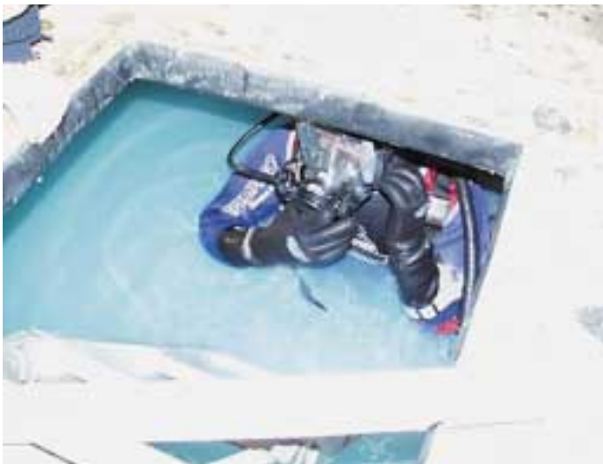
Geschafft und abtauchen durch eine der 0,80 m × 0,80 m Inspektionsöffnungen
