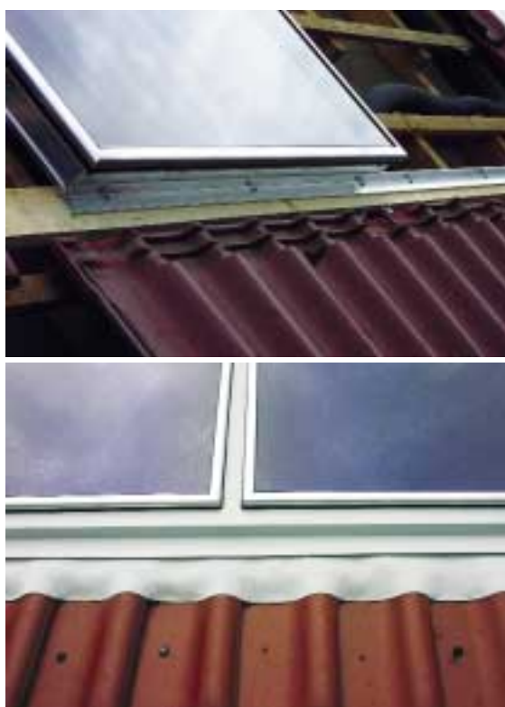
Bild 4 Indachmontage eines Flachkollektors
