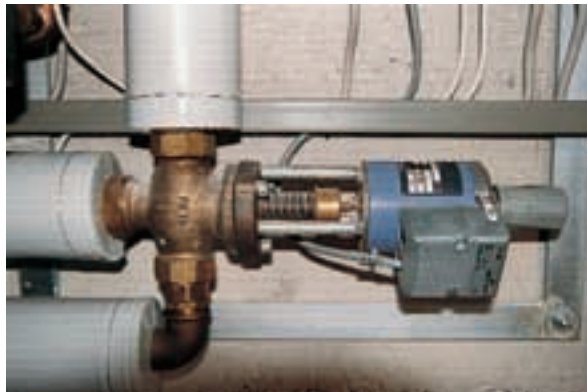
Kernstück der SaniSystem-Mischwasser-Unit ist das Magnetregelventil M3B...G../A von Siemens Landis & Staefa mit einer Stellzeit von unter 1 Sekunde
