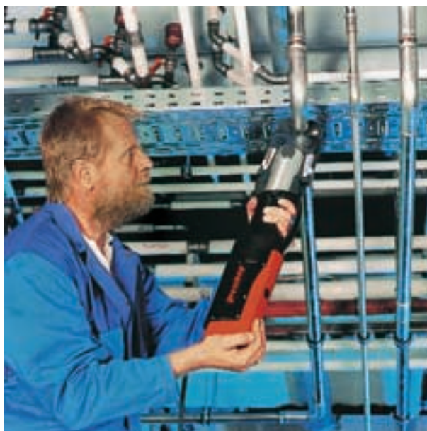
Bild 10 Die Preßverbindung an Edelstahlrohren hat sich als baustellentaugliche Verbindung durchgesetzt
