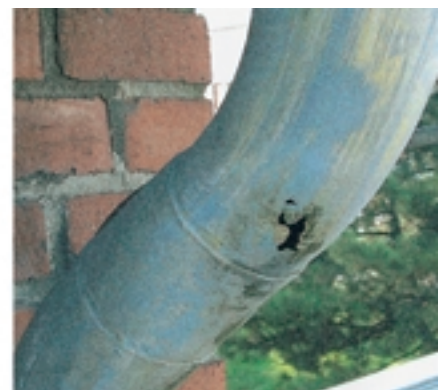
Schäden an Metallbauteilen, verursacht durch aggressive Abläufe von gegen UV-Einstrahlung ungeschützten bituminösen Dachflächen
