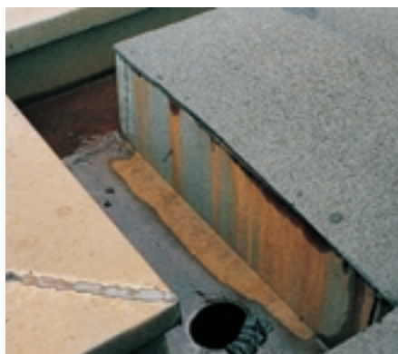
Schäden an Metallbauteilen, verursacht durch aggressive Abläufe von gegen UV-Einstrahlung ungeschützten bituminösen Dachflächen
