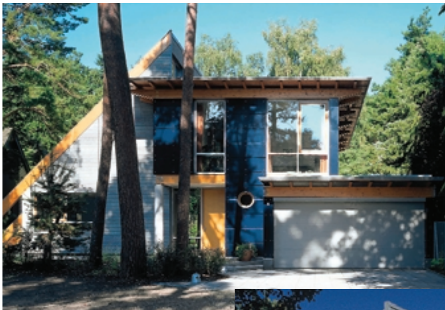
In das gestalterische Gesamtkonzept können Garagentore, die mit Rheinzink „vorbewittert“ bekleidet sind, integriert werden
