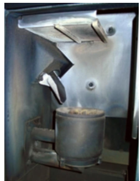
Bild 4 Brennstoffzuführung im Abwurfverfahren: Die Holzpellets gelangen über den Fallschacht in den Brennertopf
