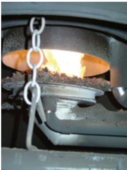
Bild 5 Bei der Unterschubfeuerung gelangen die Holzpellets von unten in die Feuermulde
