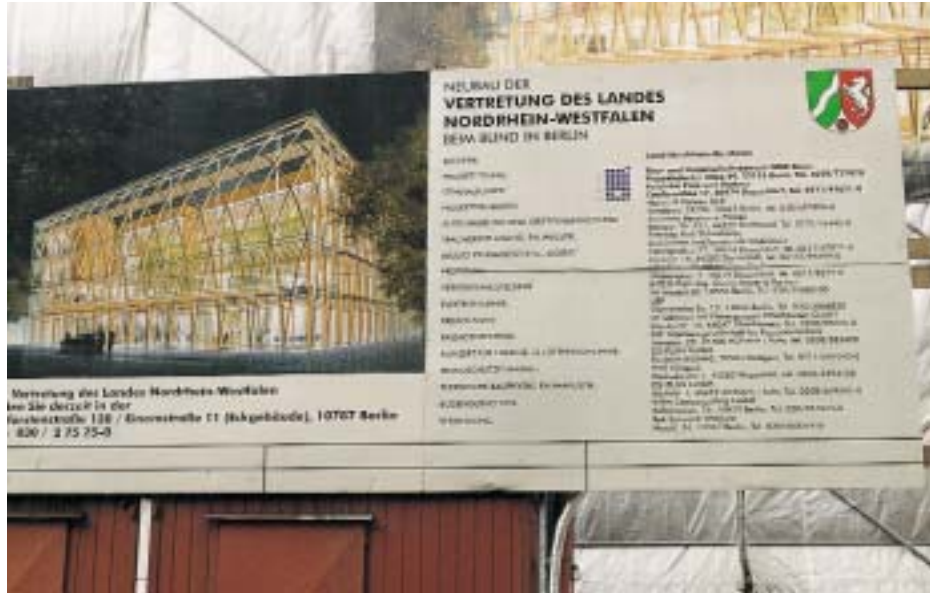
Weil die Doppelfassade erst später eingehängt wird, ist der Neubau der Vertretung des Landes NRW beim Bund in Berlin noch verhangen, um die Parabeln der Holzleimbinder-Konstruktion gegen Witterungseinflüsse zu schützen
