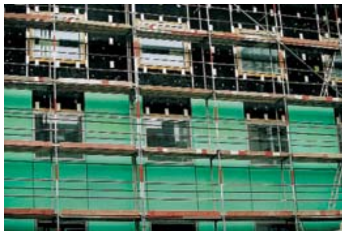
Die Kupferbekleidung ist etwa zur Hälfte fertiggestellt; darüber sind die kaschierte Wärmedämmung und die vormontierten Befestigungselemente zu erkennen
