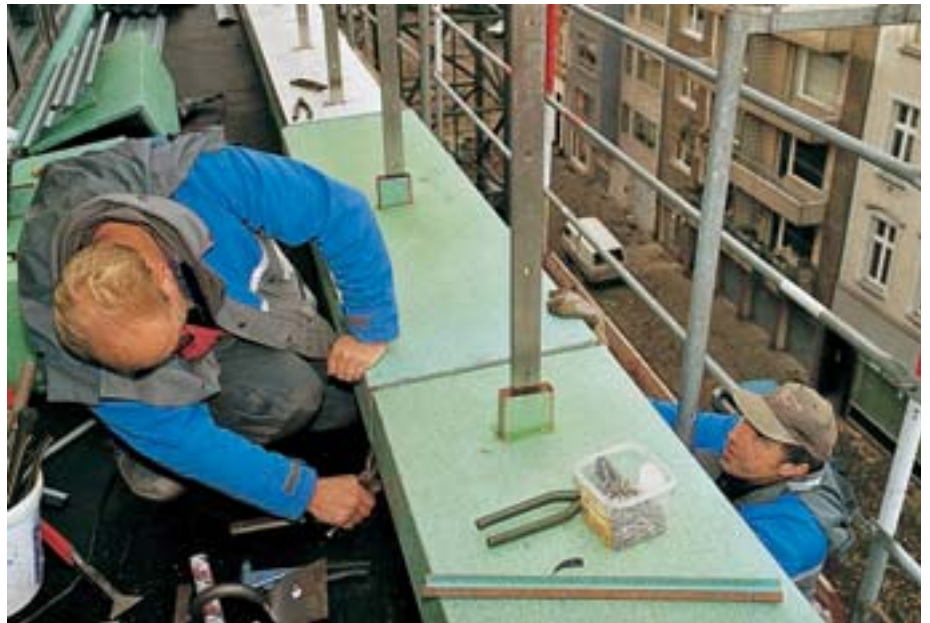
Einbau vorgefertigter kupferner Attika-Abdeckungen, die zusätzlich mit Blech-Kaltkleber auf der Al-Trapezblech-Unterkonstruktion aufgeklebt sind
