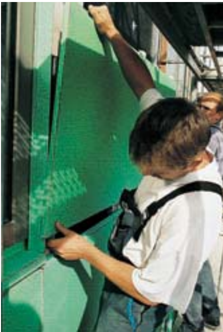
Einpassen eines vorgefertigten Bekleidungs-elementes an einer Fensterleibung
