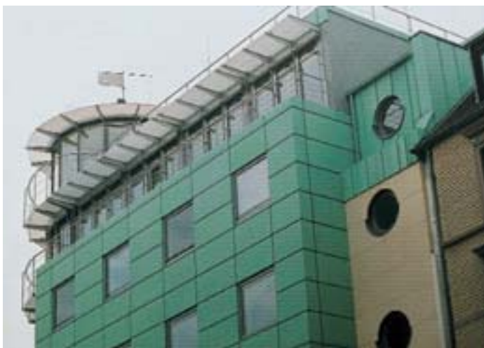
Die prägnante Kupferfassade zeigt sich als bemerkenswertes Stück zeitgemäßer Klempnertechnik
