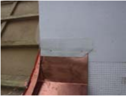
Bild 9 Wandanschluß an einem Steildach mittels Dünnputzprofil
