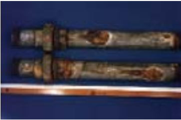
Bild 8 Ständige oder zyklisch wiederkehrende Überschreitungen der Spezifikationen führen zu Korrosion oder Rißbildung
