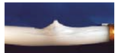
Bild 9 Direkter Kaltwasseranschluß an einen gasbetriebenen Durchlauferhitzer mittels PEX-Rohr
