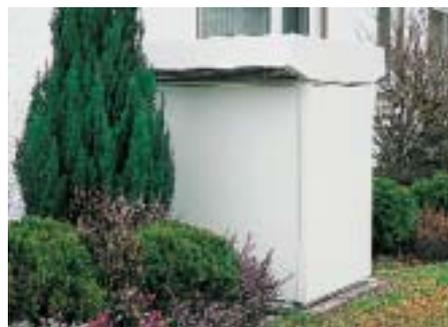
tragen sowohl VDE/GS- als auch CE-Zeichen. Auf Grund ihrer Technik und einem leistungsstarken Scroll-Verdichter entziehen die Geräte nach Herstellerangaben auch unter widrigen Umständen der Außenluft noch Wärme und speisen sie in die Heizung ein.
