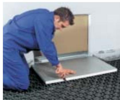
Kombi-Set an, das eine saubere und dichte Rohrverlegung im Bereich der Türrdurchgänge und vor den Verteilern ermöglicht. Vor dem Verteilerschrank wird die Noppelplatte ausgeschnitten und gegen die planebene Verteileranschlußplatte ausgetauscht. Mit den enthaltenen Tackernadeln können danach die Rohre an beliebiger Stelle auf der Platte fixiert werden.
