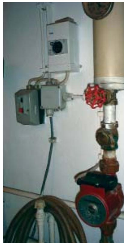
Energie sparen: WW-Zirkulationspumpe ohne Zeitsteuerung
