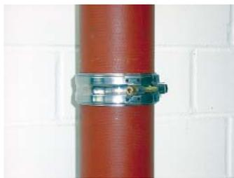
eine Verschlußschraube und ist die montagefertige Rohrverbindung für SML-Rohr- und Formstücke. Sein profiliertes Schellenkörper gewährleistet eine sichere und stabile Rohrverbindung. Der Rohrverbinder Duplo ist der geeignete Verbinder bei Reparaturen und Änderungen an bestehenden Rohrsystemen. Die zwei Verschlußschrauben bieten
