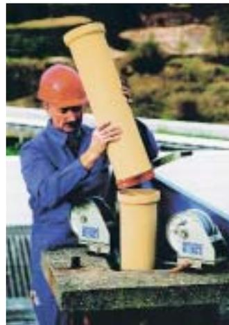
bunden und die Muffen mit einem speziellen Säurekitt abgedichtet. Durch die dünnen Wandungen von nur 8 mm lassen sich selbst enge Schächte mit der keramischen Rauchgasführung versehen.
