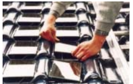
Diese kleinen Solarmodule lassen sich nachträglich auf dem Solar-Dachziegel befestigen. Zuvor werden unter dem Dach jeweils Kabelkanäle und Elektroleitungen verlegt (Laumanns)
