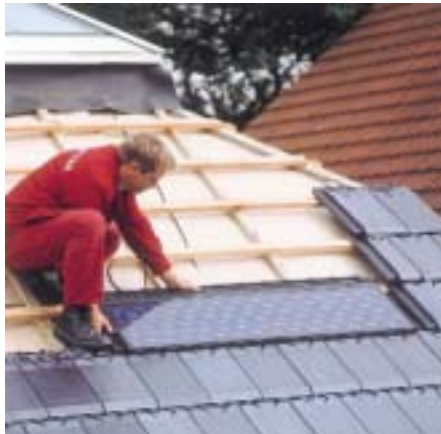
Das Photovoltaikmodul „Terra Piatta-Solar“ (Deckbreite: 1348–1364 mm) wird sowohl mit mono- als auch polykristallinen Zellen angeboten (Dachziegelwerke Pfeleiderer)
