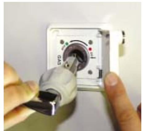
**Bild 2** Die neuen Gas-Steckdosen sind eine wichtige Voraussetzung für das erdgasvollversorgte Haus. Seit einigen Wochen produziert Dingerkus sie in Serie
