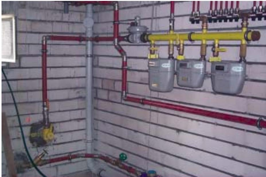
**Bild 10 Gasinstallation mit Kunststoffverbundrohr, Gaszählern, Gasverteilern, Gas-Strömungs- und Rückstauwächtern im Demo-Haus Solingen**
