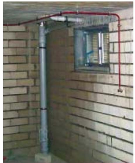
**Bild 12 Ungewohnt – der Anschluß für den Gas-Wäschetrockner**
