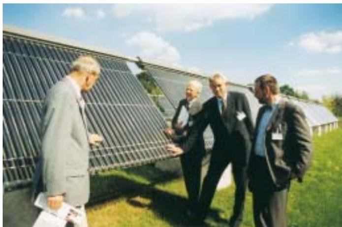
**Die zum Antrieb der Kältemaschine notwendige Wärmeenergie liefern 24 Vakuumröhren-Kollektoren mit insgesamt 720 Röhren**
