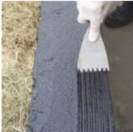
*Der Kleber wird gleichmäßig mit dem Rillenspachtel in eine Richtung verteilt . . .*
