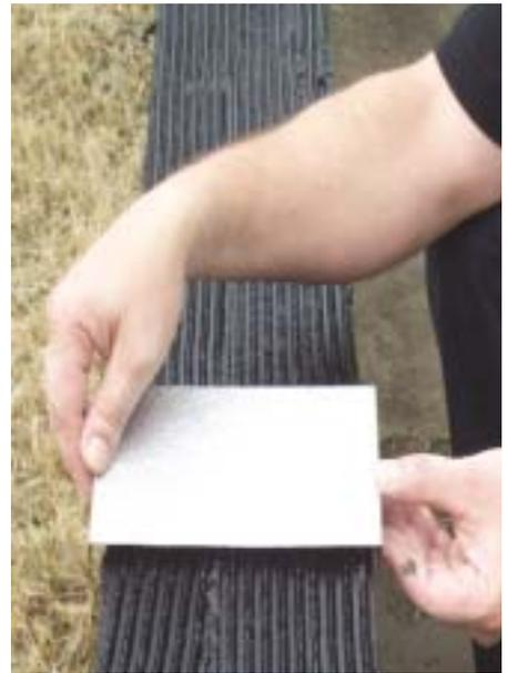
*Bei Abdeckungen die aus mehreren Einzelteilen bestehen wird unter den Blechfugen ein Unterblech eingeklebt*
