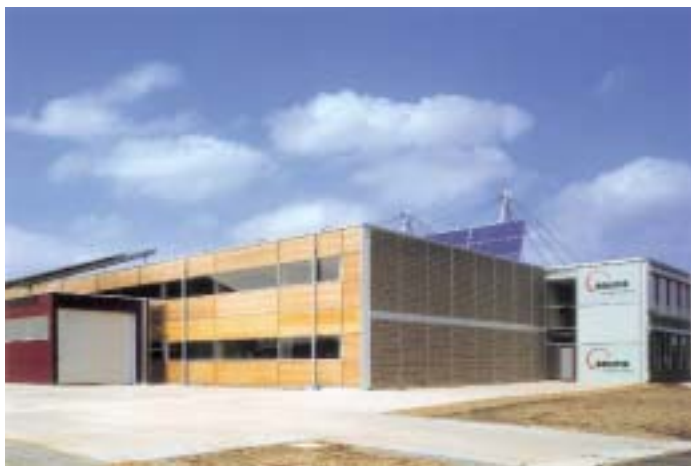
Die Versorgung des neuen Firmengebäudes besteht aus 100 % regenerativen Energien, darunter 30 % solarer Anteil
