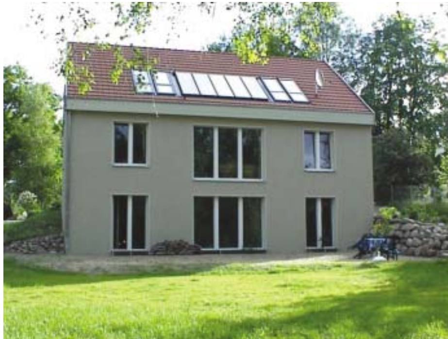
Das Passivhaus von Reinhard Kunow greift zur Deckung des Wärmebedarfes auf solare Reserven und kontrollierte Wohnraumlüftung zurück
