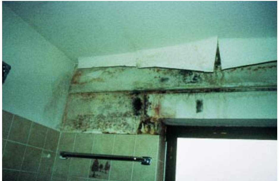
Besonders anfällig sind Bauteile, die aufgrund mangelnder Wärmedämmung als Abkühlungs- und damit Kondensationsfläche für die im Raume befindliche Luftfeuchtigkeit dienen
